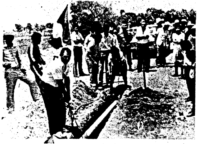
Franz Carbajal y Sra. Colocan el primer tubo de la red que conducirá agua potable a Bombón.
