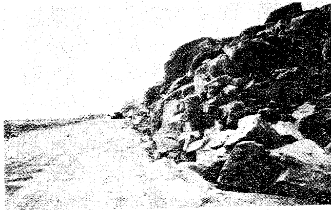
Carretera Ilo-Valle de Tambo-El Fiscal: se observan avances muy lentos en los últimos años por restricciones presupuestales.
